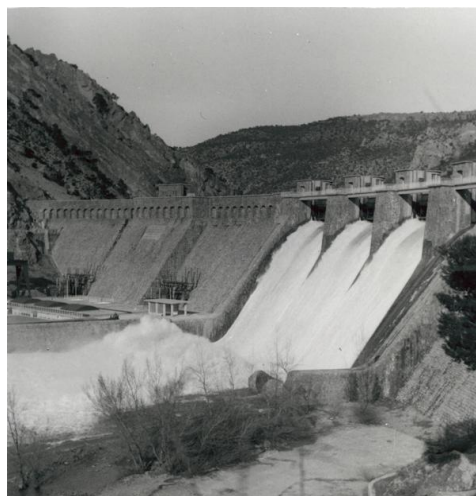
Recrecimiento de la presa en 1960 Cortesía Gas Natural Fenosa
